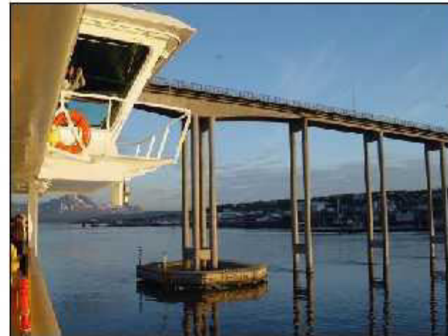
Stø kurs mellom bropillarene på Tromsøbrua.
